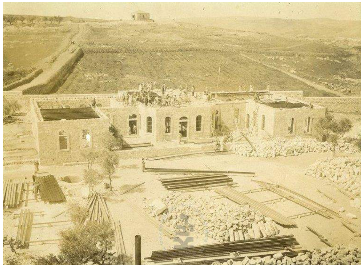
תהליך הבנייה: קומה א' – רלסים בהנחה; חומרי הבניין בחצר; אבנים מסותתות מוכנות, סביבות 1901, מתוך ארכיון הצילומים של יד יצחק בן-צבי
