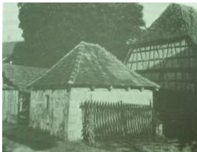
מאפיה ציבורית באזור טיבויגן יש לשים לב לעיבוד הגס בקירות ולסיתות המעודן בפינות הבית ובפתח החלון
