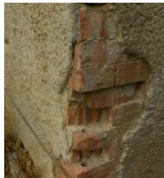
טיח אומנותי אשלית אבן אופייני לבניה באירופה ללא אבן משמש באופן גורף לחיפוי ועיצוב חזיתות. במתחם שנלר נעשה שימוש בטכנולוגיה זו בחזיתות מערביות החשופות לגשם (לא רק על לבנים אלא אף כחיפוי /איטום חזיתות אבן מערביות), מתוך תיק התיעוד של 'בית הצריח', משה שפירא
