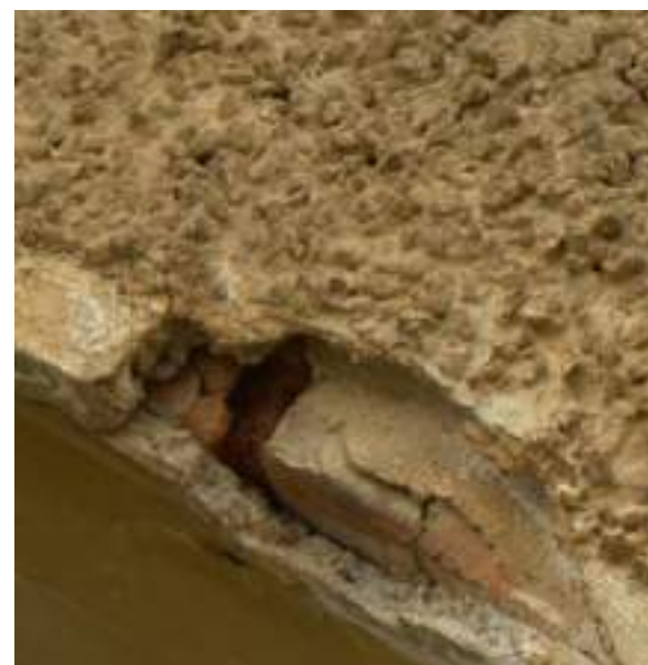
טיח אומנותי אשלית אבן אופייני לבניה באירופה ללא אבן משמש באופן גורף לחיפוי ועיצוב חזיתות. במתחם שנלר נעשה שימוש בטכנולוגיה זו בחזיתות מערביות החשופות לגשם (לא רק על לבנים אלא אף כחיפוי /איטום חזיתות אבן מערביות), מתוך תיק התיעוד של 'בית הצריח', משה שפירא
